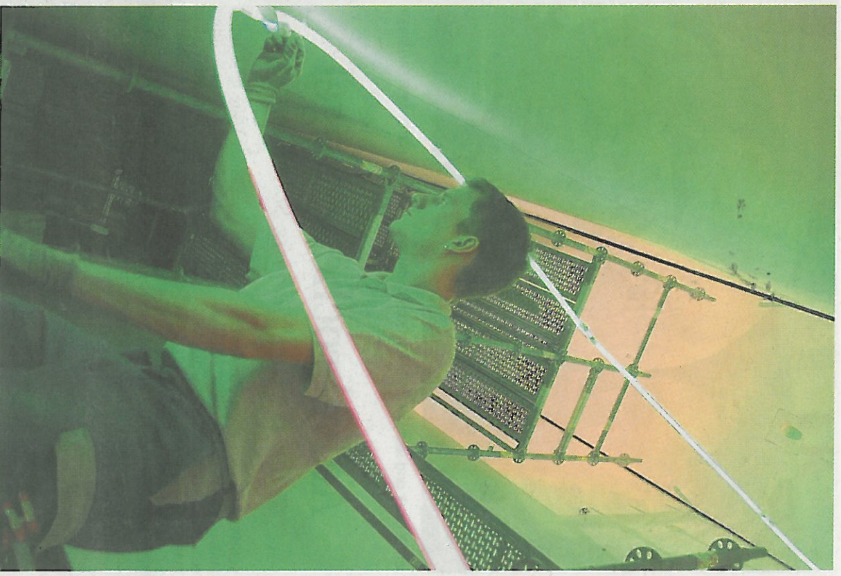
Benjamin Hellstern, Elektriker im Team von Chris Nägele, bei der diffizilen Montage der Lichtinstallation „Freischwimmer“.
